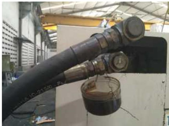
Gambar. 1 kondisi swivle joint yang mengalami kebocoran oli
